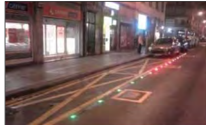
Foto 33. Zona de carga y descarga con reserva dinámica de plaza
