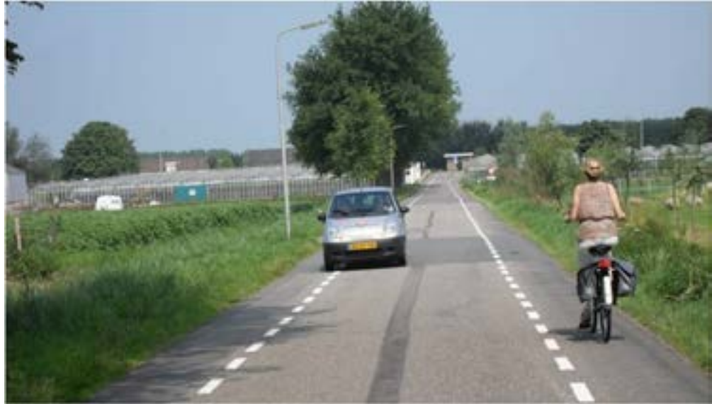
Ilustración nº 3: Exemplo de circulación por bandas de protección cun único carril.
